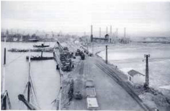
Instalaciones portuarias Sagunto
